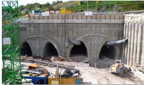
PFA 1.5 Tunnel Bad Cannstatt Vortrieb 3.176m
