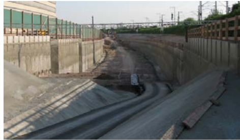
PFA 1.5 S-Bahn – Mitternachtstr. Aushub entspricht ca. 465m (Länge)
