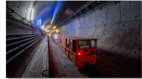
PFA 1.2 Fildertunnel Anlieferung Tübbinge Vortrieb 3.950 m
