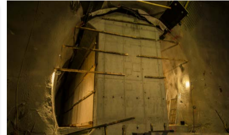
PFA 1.2 Rettungszufahrt Hbf Süd Herstellung Verzweigungsbauwerk Pfeilerstollen Ost
