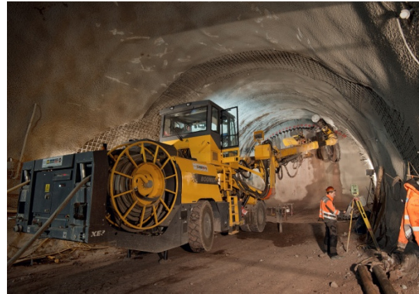
PFA 1.2 Rettungszufahrt Wagenburg Rohrschirmbohren Kalotte TM 198 (von TM 222)
