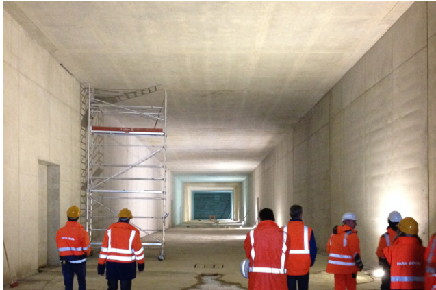
PFA 1.5 S-Bahn - Engstelle Erstes Teilstück Rohbau fertiggestellt
