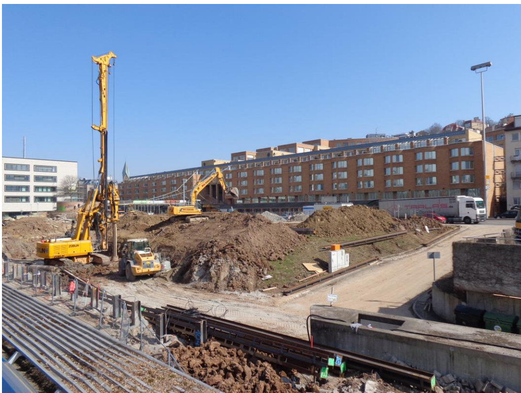
Abbildung 1: Blick auf das Baufeld bei Messbeginn am 20.04.2015
