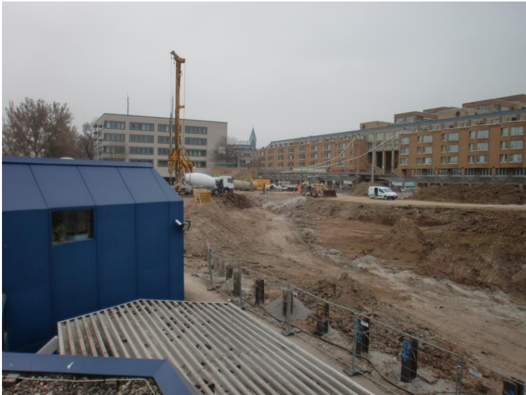
Abbildung 2: Blick auf das Baufeld bei Messende am 23.03.2015
