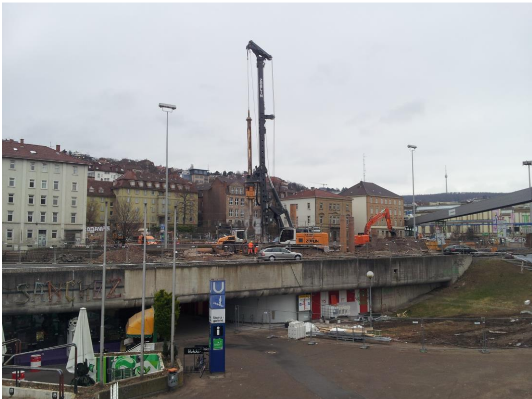
Abbildung 1: Blick auf das Baufeld bei Messbeginn am 09.02.2015
