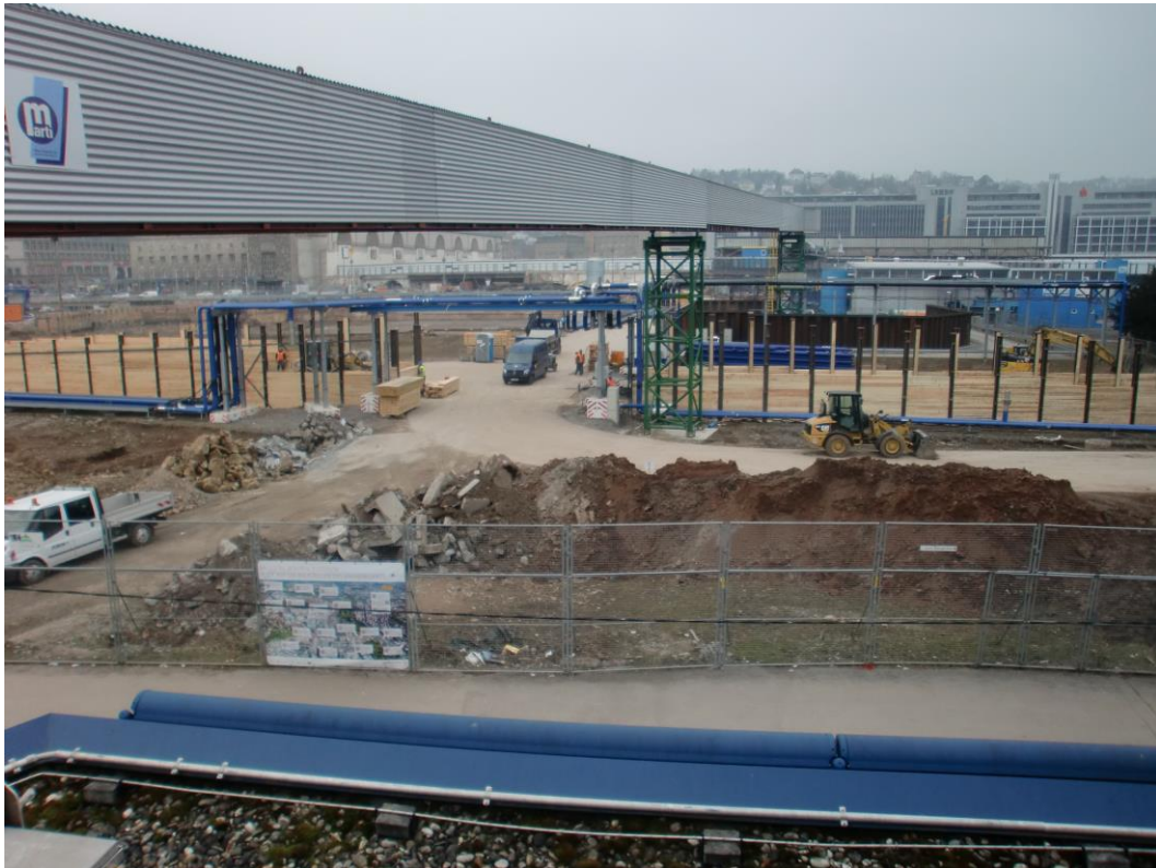
Abbildung 2: Blick auf das Baufeld bei Messende am 16.02.2015
