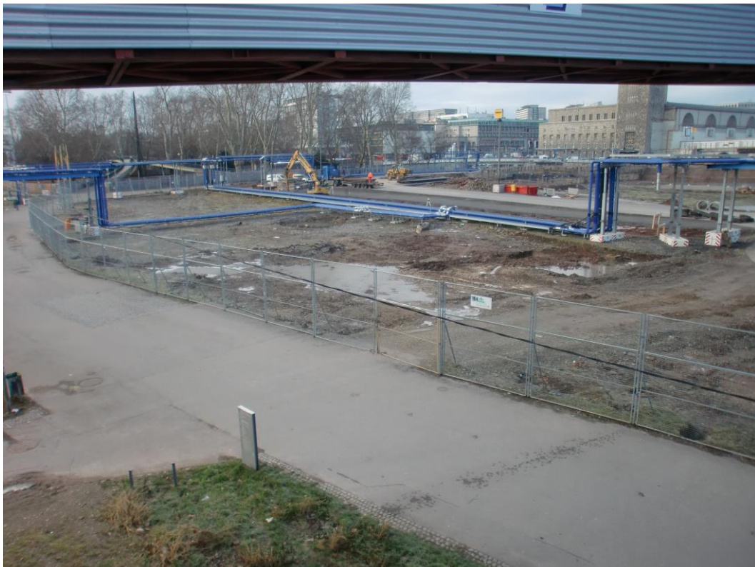
Abbildung 1: Blick auf das Baufeld bei Messbeginn am 19.01.2015
