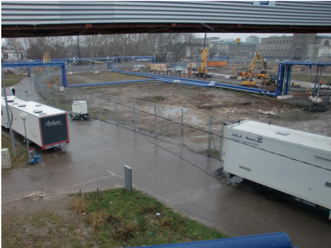
Abbildung 2: Blick auf das Baufeld bei Messende am 26.01.2015
