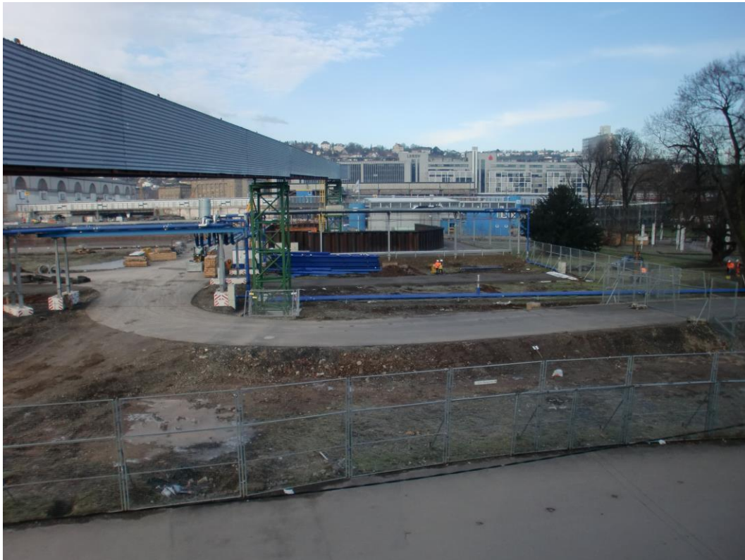
Abbildung 2: Blick auf das Baufeld bei Messende am 19.01.2015
