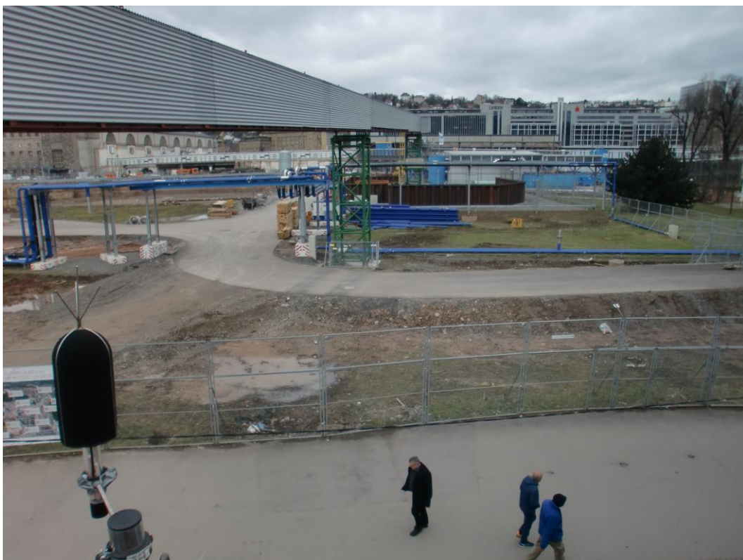
Abbildung 1: Blick auf das Baufeld bei Messbeginn am 12.01.2015
