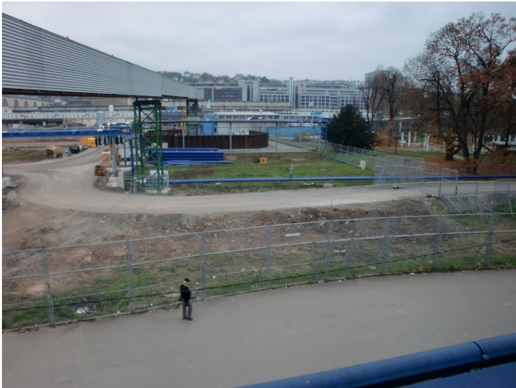
Abbildung 2: Blick auf das Baufeld bei Messende am 01.12.2014
