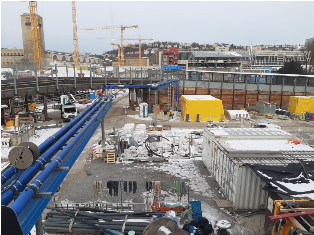
Abbildung 2: Blick auf das Baufeld bei Messende am 15.02.2021
