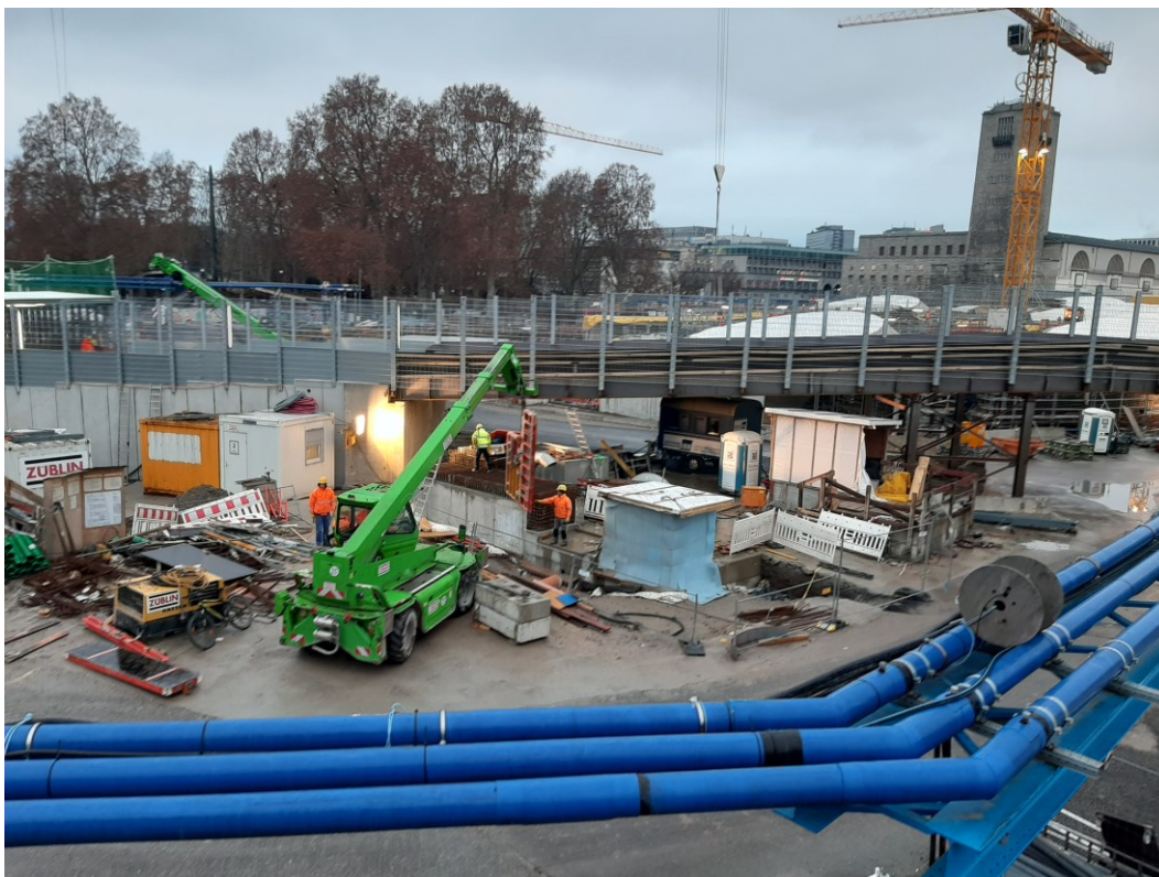
Abbildung 2: Blick auf das Baufeld bei Messende am 08.02.2021
