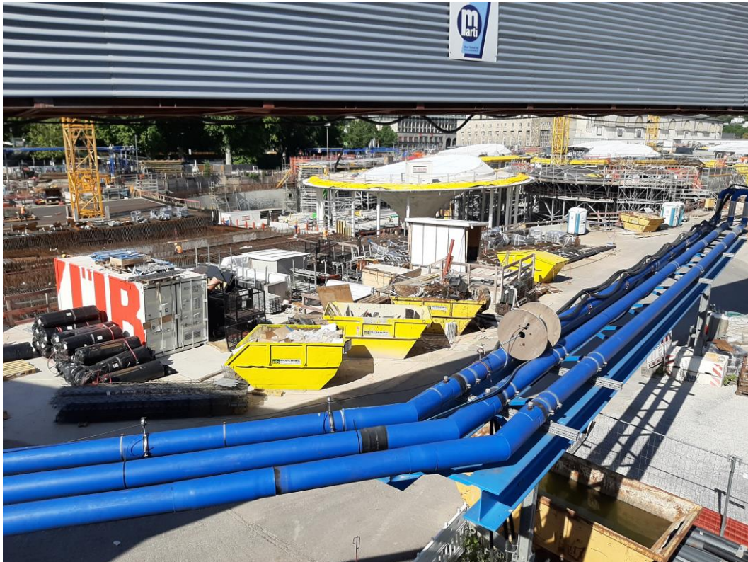
Abbildung 2: Blick auf das Baufeld bei Messende am 12.07.2020
