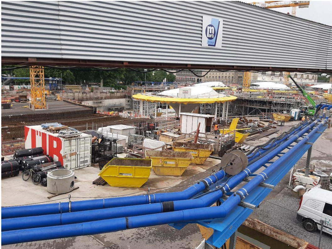
Abbildung 2: Blick auf das Baufeld bei Messende am 28.06.2020
