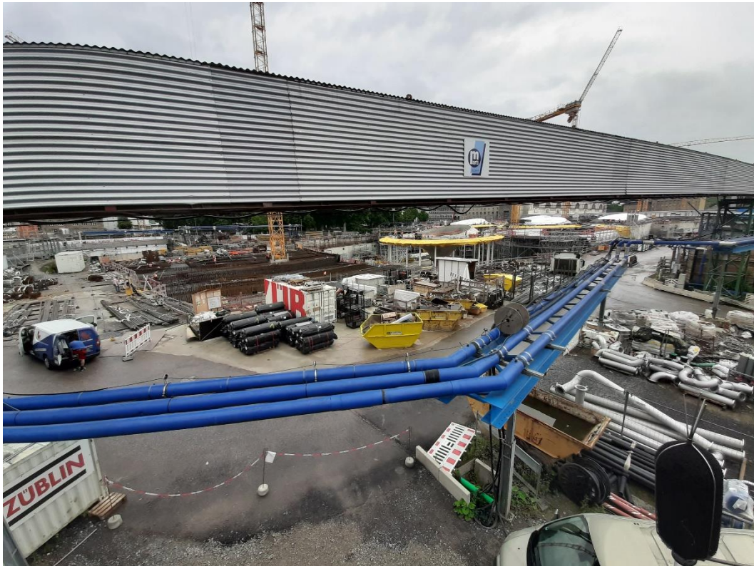
Abbildung 2: Blick auf das Baufeld bei Messende am 15.06.2020
