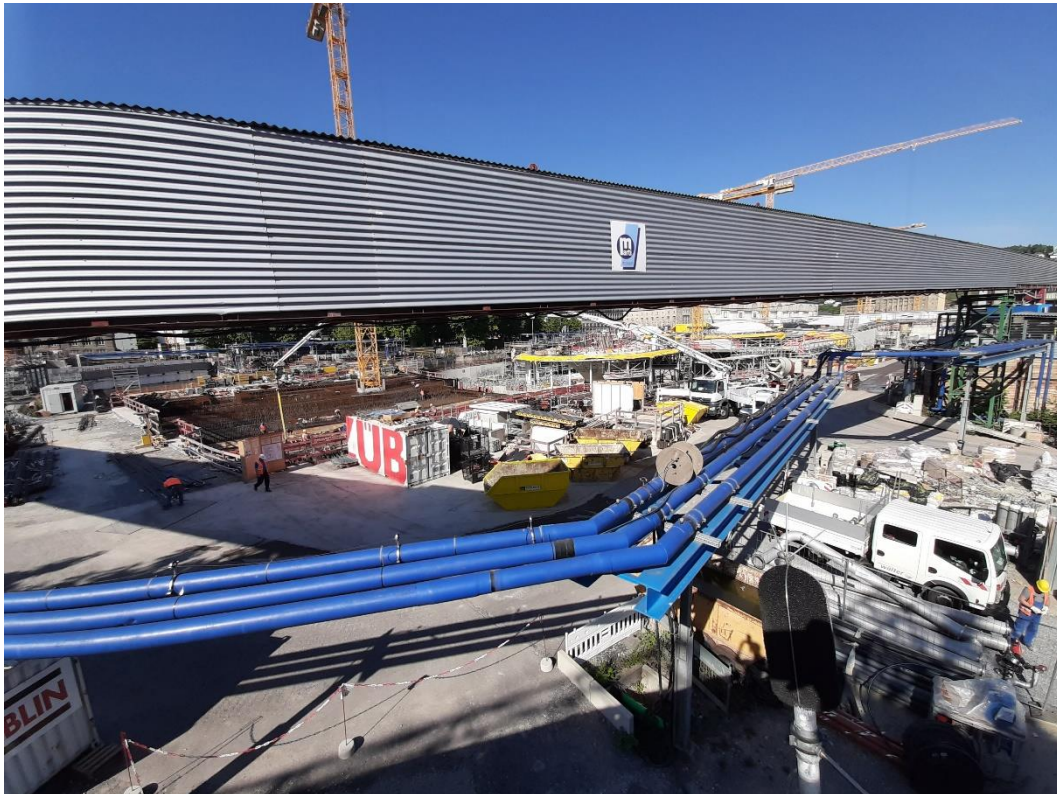
Abbildung 2: Blick auf das Baufeld bei Messende am 02.06.2020
