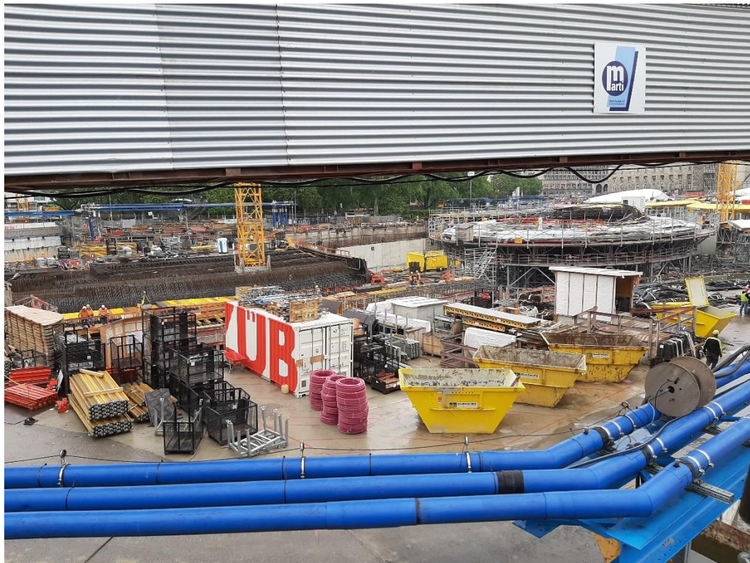
Abbildung 2: Blick auf das Baufeld bei Messende am 18.05.2020
