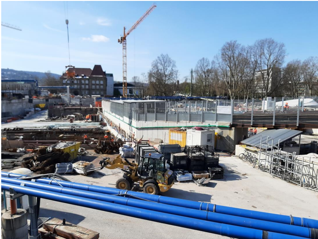
Abbildung 2: Blick auf das Baufeld bei Messende am 04.04.2022
