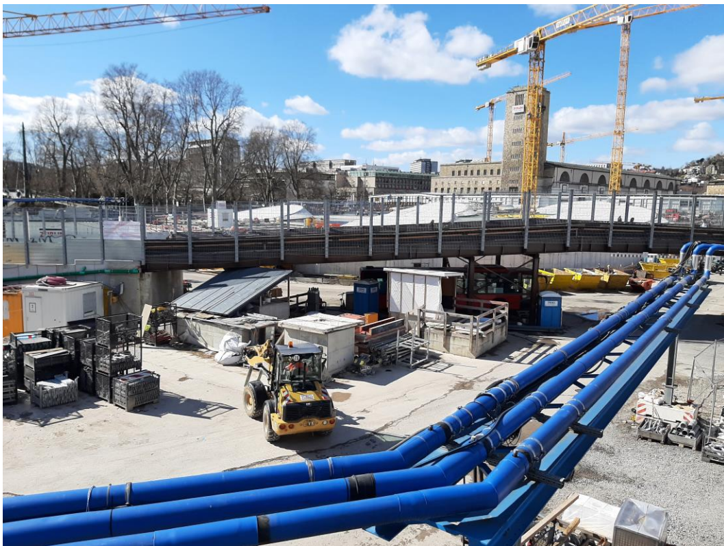
Abbildung 1: Blick auf das Baufeld bei Messbeginn am 14.03.2022
