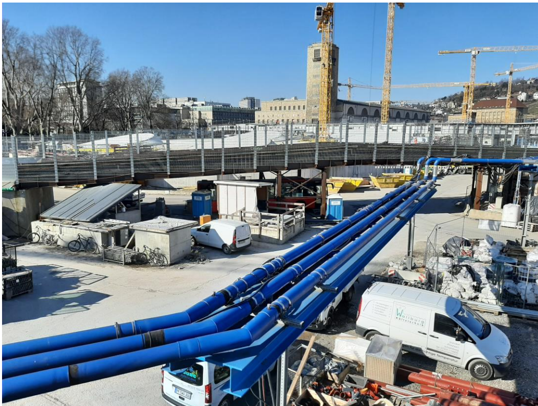
Abbildung 2: Blick auf das Baufeld bei Messende am 28.02.2022
