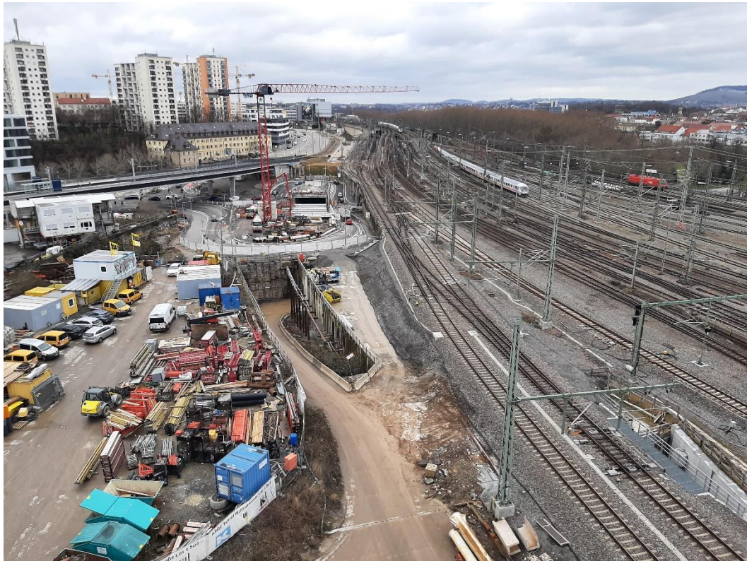
Abbildung 2: Blick auf das Baufeld bei Messende am 07.02.2022
