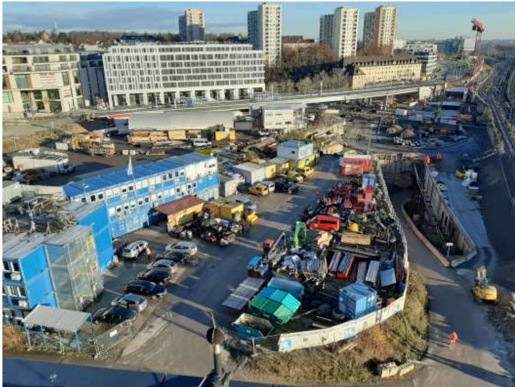
Abbildung 2: Blick auf das Baufeld bei Messende am 14.12.2020
