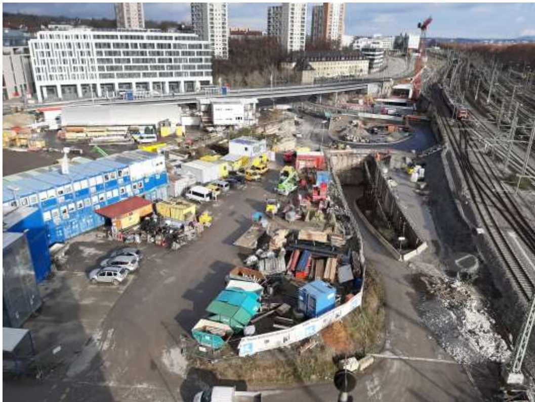
Abbildung 2: Blick auf das Baufeld bei Messende am 07.12.2020
