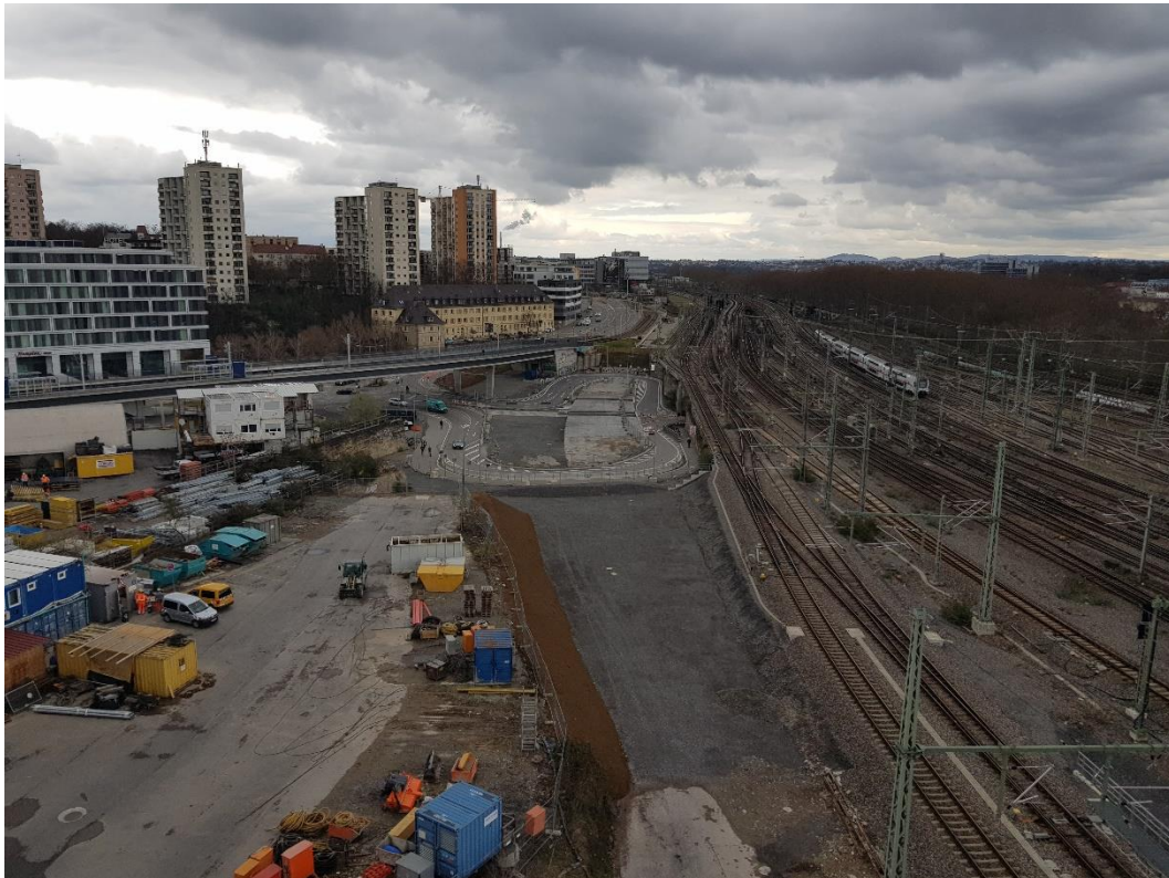
Abbildung 2: Blick auf das Baufeld bei Messende am 20.03.2023
