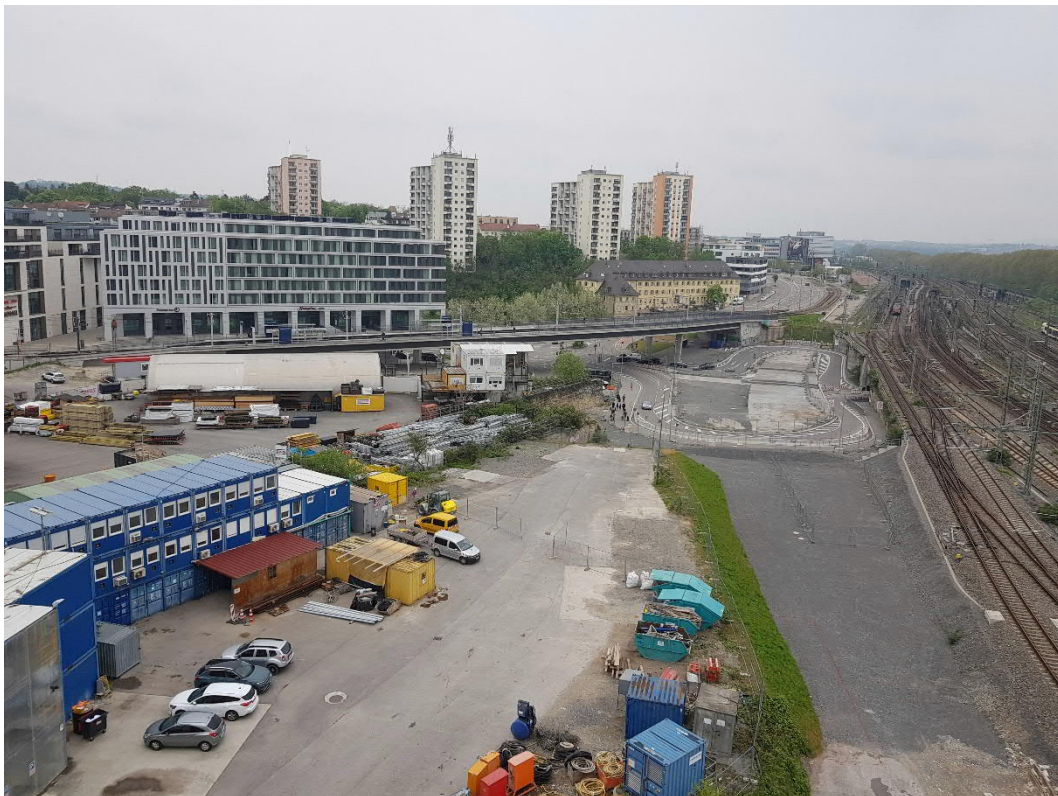
Abbildung 2: Blick auf das Baufeld bei Messende am 02.05.2023
