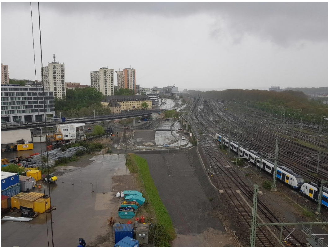
Abbildung 1: Blick auf das Baufeld bei Messbeginn am 25.04.2023
