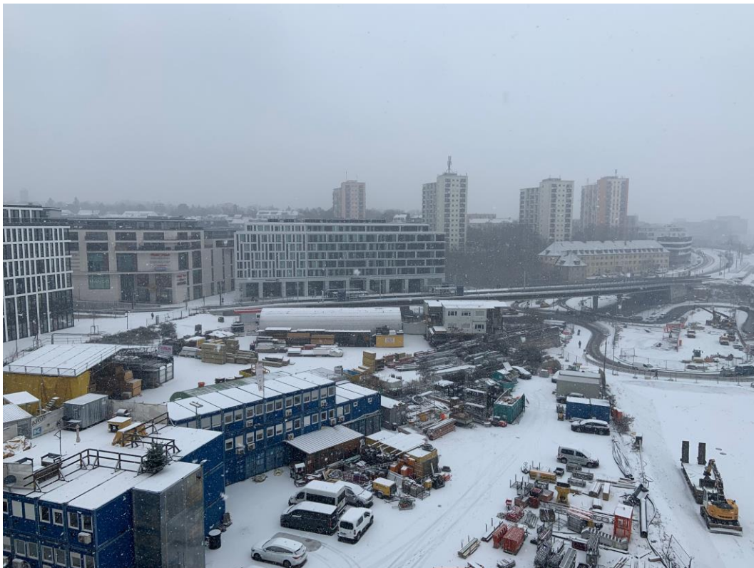
Abbildung 2: Blick auf das Baufeld bei Messende am 19.12.2022
