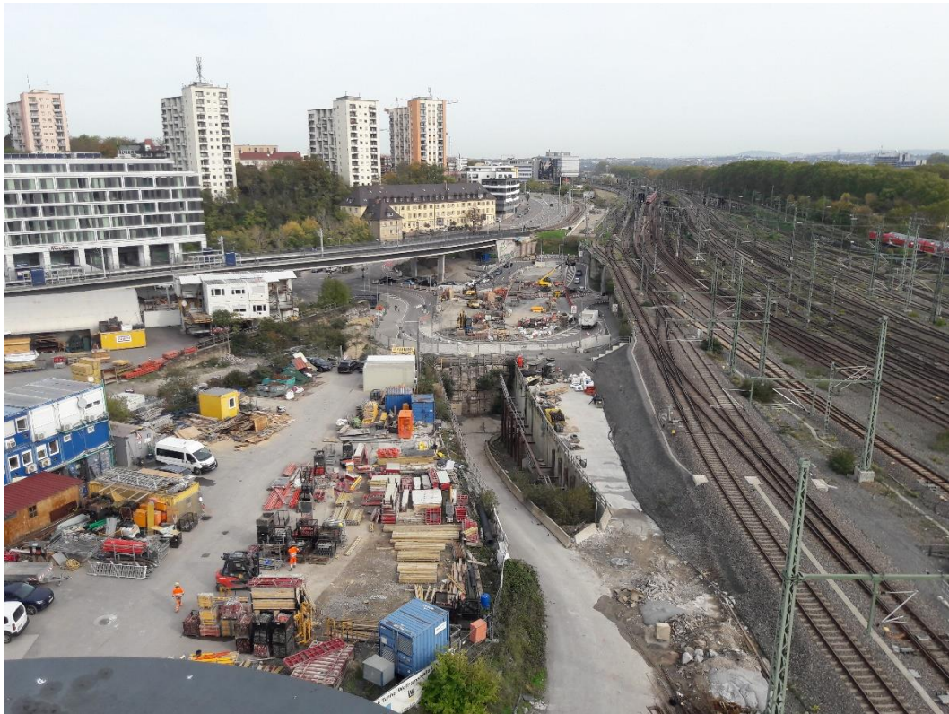
Abbildung 2: Blick auf das Baufeld bei Messende am 28.11.2022
