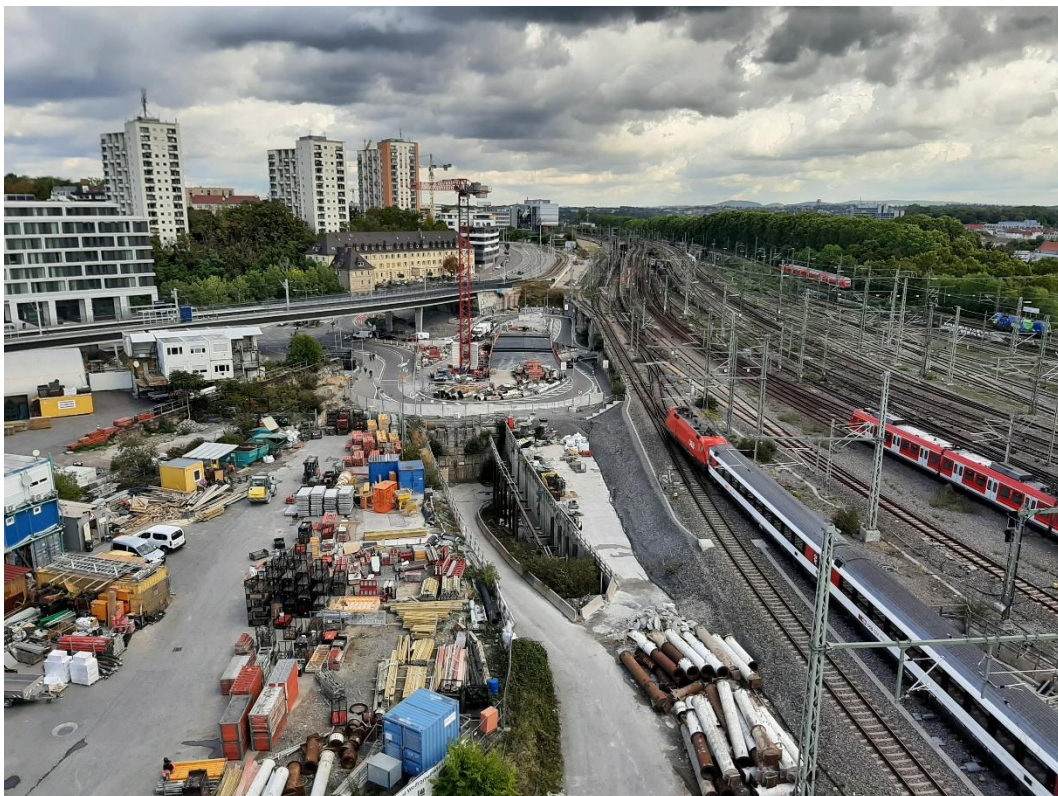
Abbildung 1: Blick auf das Baufeld bei Messbeginn am 26.09.2022
