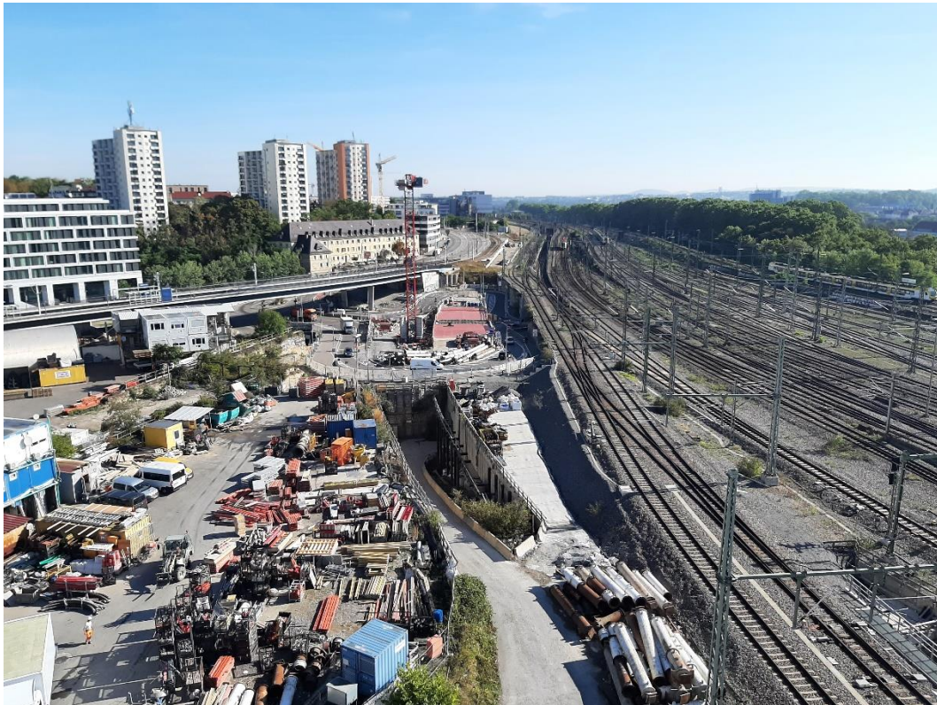
Abbildung 2: Blick auf das Baufeld bei Messende am 12.09.2022
