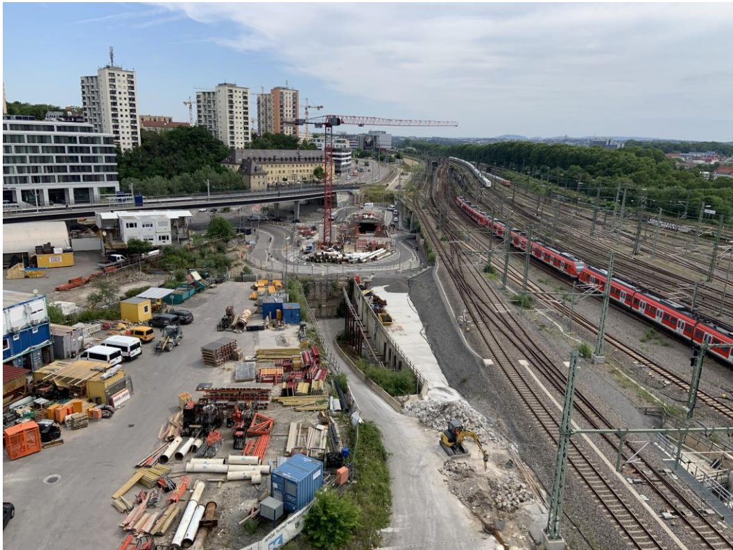
Abbildung 2: Blick auf das Baufeld bei Messende am 04.07.2022
