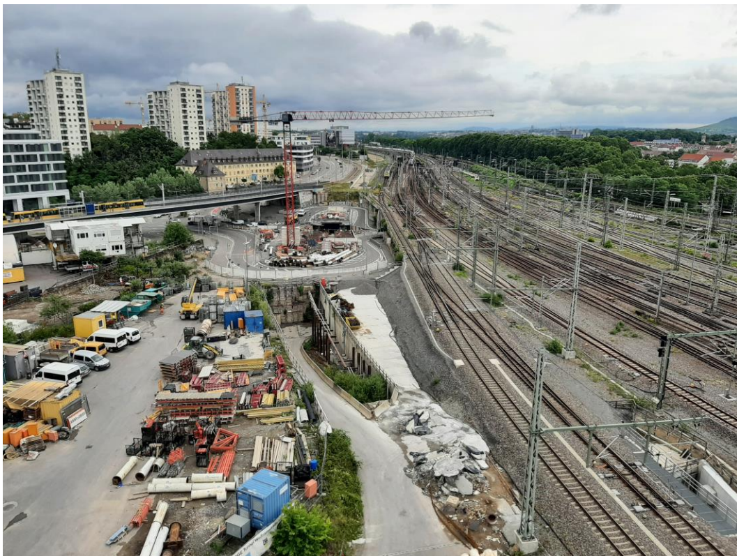
Abbildung 1: Blick auf das Baufeld bei Messbeginn am 27.06.2022
