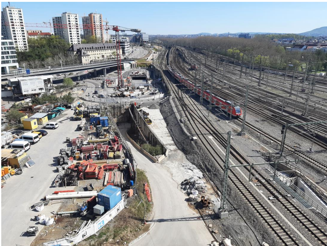
Abbildung 1: Blick auf das Baufeld bei Messbeginn am 11.04.2022
