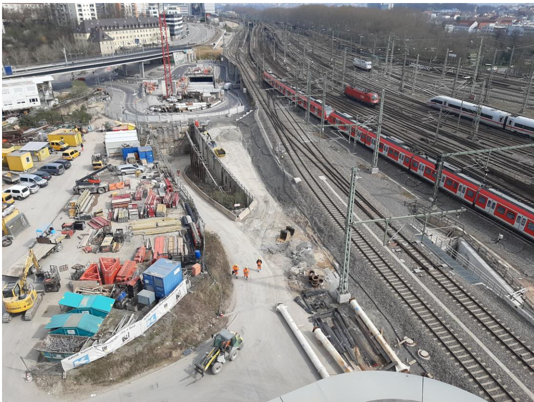
Abbildung 1: Blick auf das Baufeld bei Messbeginn am 21.03.2022
