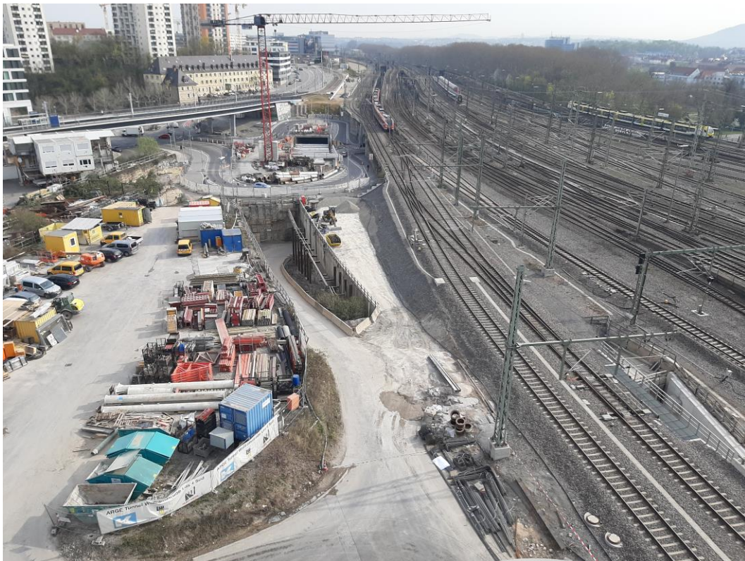
Abbildung 2: Blick auf das Baufeld bei Messende am 28.03.2022
