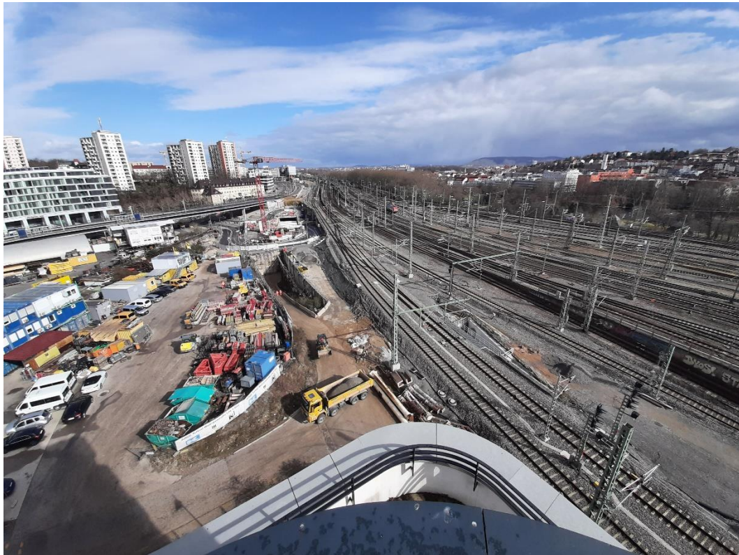
Abbildung 2: Blick auf das Baufeld bei Messende am 21.03.2022
