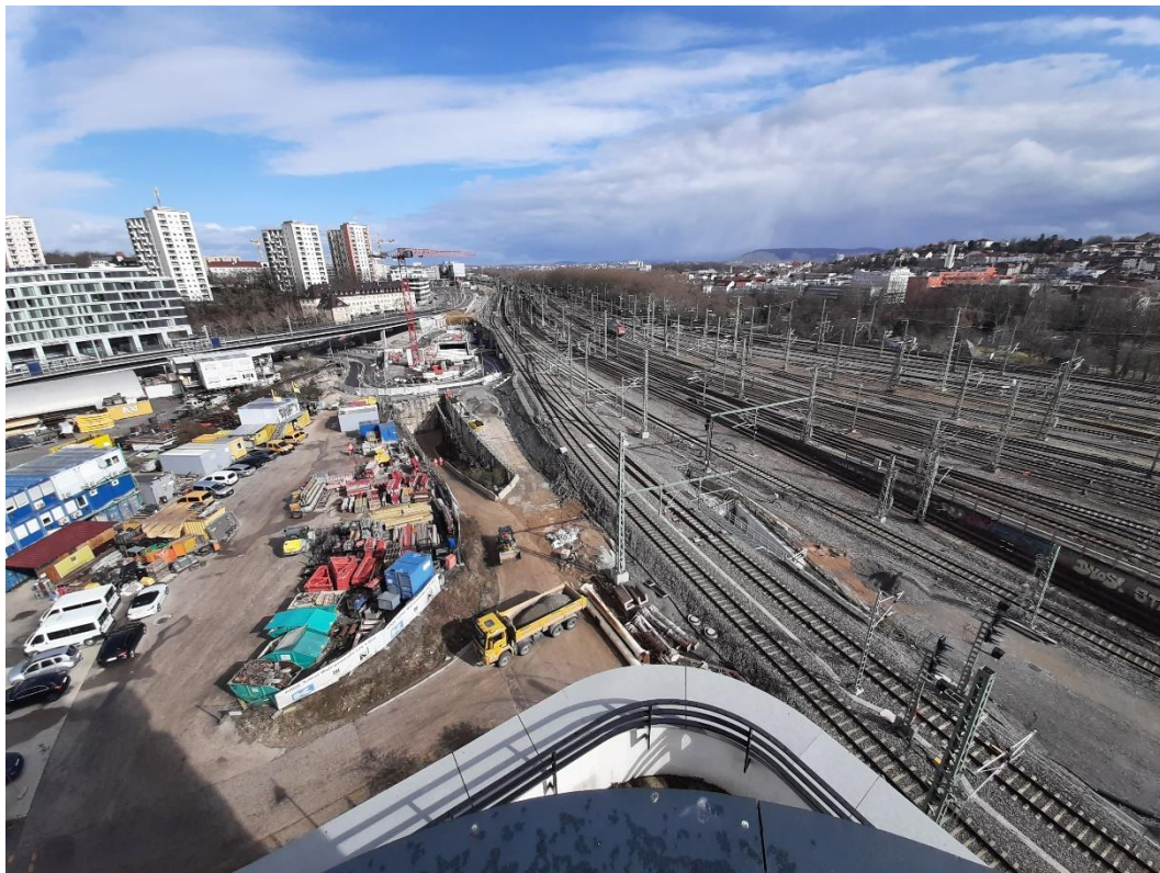
Abbildung 2: Blick auf das Baufeld bei Messende am 28.02.2022
