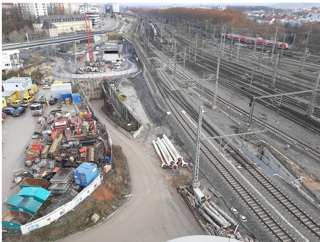
Abbildung 1: Blick auf das Baufeld bei Messbeginn am 29.11.2021
