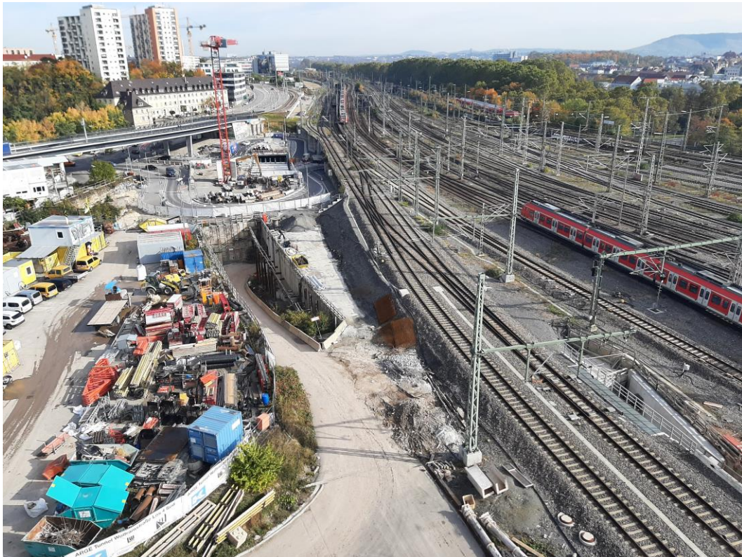
Abbildung 2: Blick auf das Baufeld bei Messende am 15.11.2021
