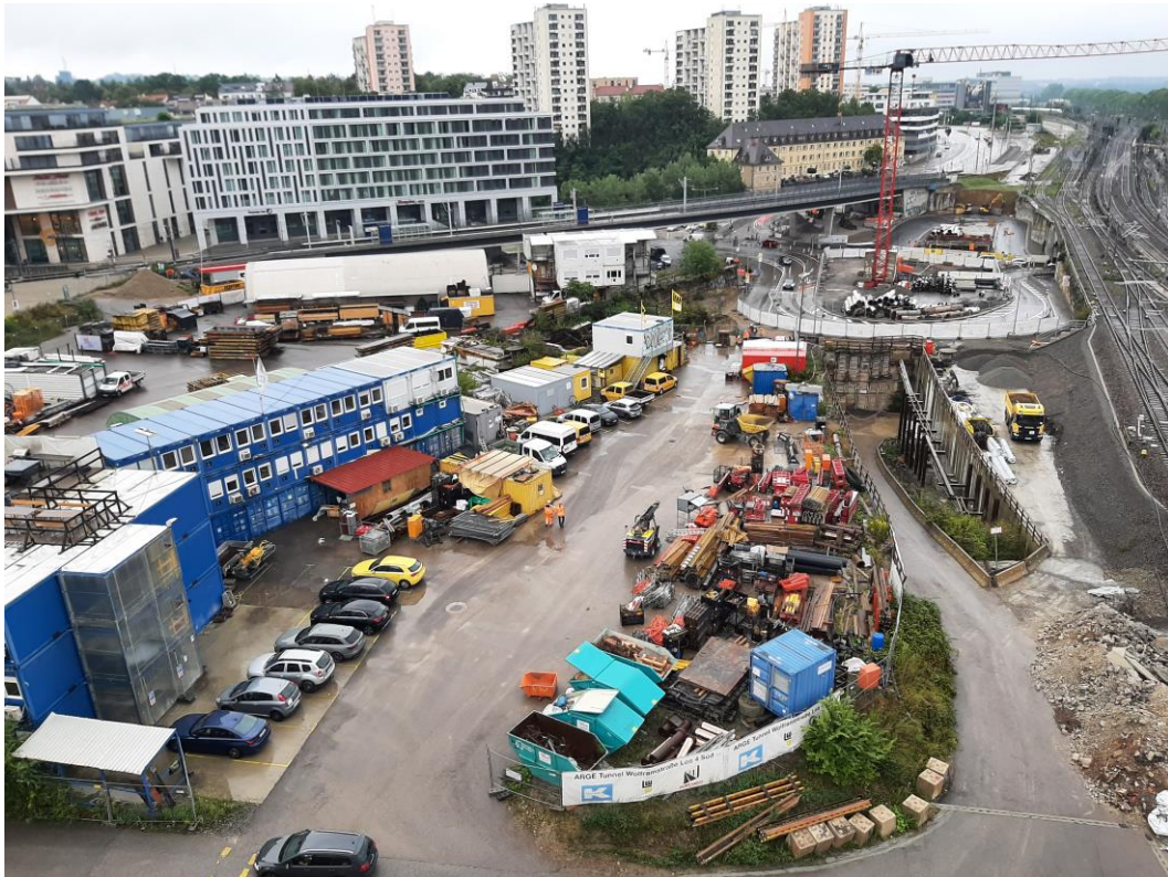
Abbildung 2: Blick auf das Baufeld bei Messende am 30.08.2021
