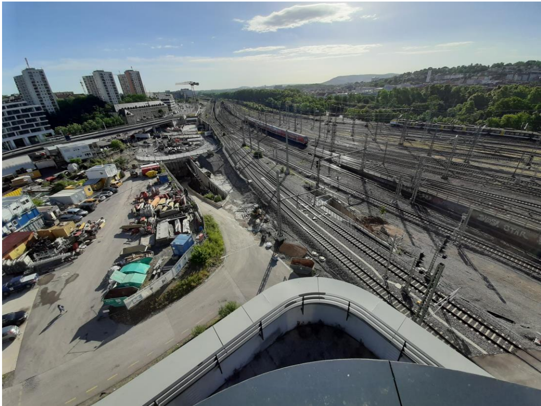
Abbildung 2: Blick auf das Baufeld bei Messende am 21.06.2021
