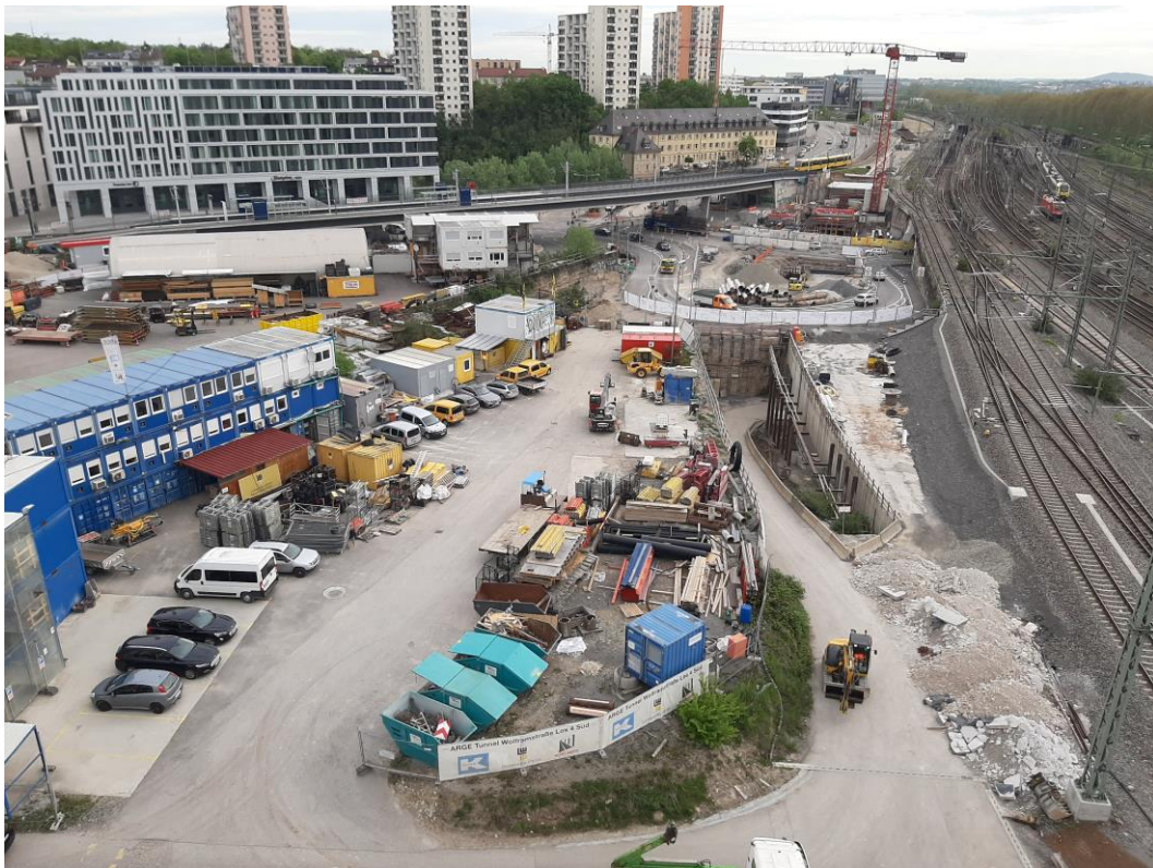
Abbildung 2: Blick auf das Baufeld bei Messende am 10.05.2021
