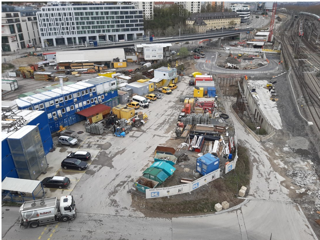
Abbildung 2: Blick auf das Baufeld bei Messende am 12.04.2021
