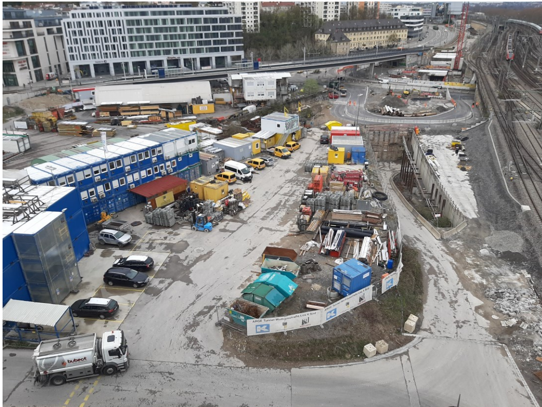
Abbildung 2: Blick auf das Baufeld bei Messende am 05.04.2021
