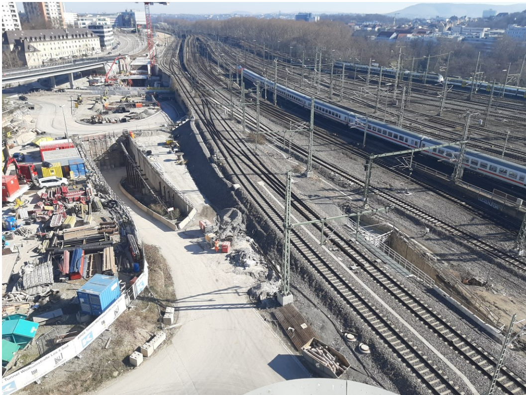
Abbildung 1: Blick auf das Baufeld bei Messbeginn am 01.03.2021
