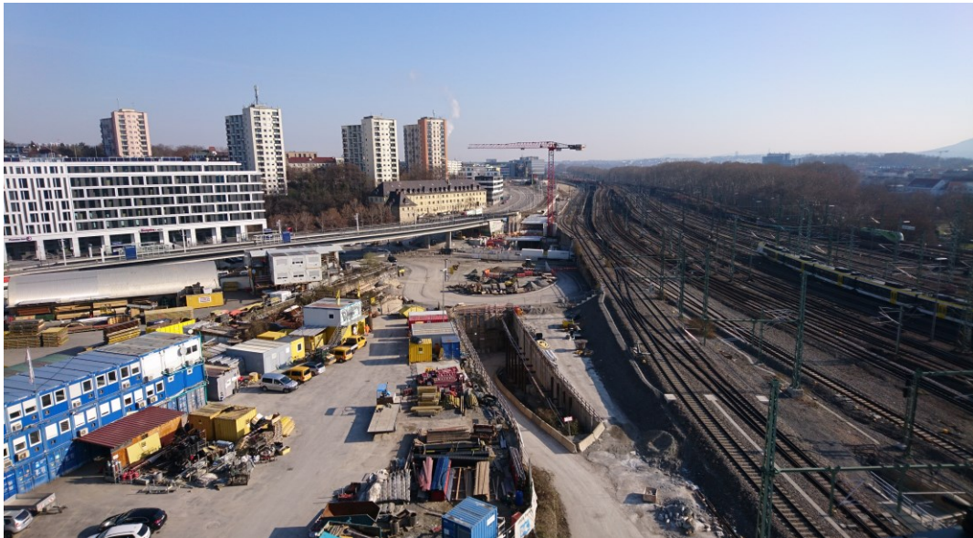
Abbildung 2: Blick auf das Baufeld bei Messende am 08.03.2021
