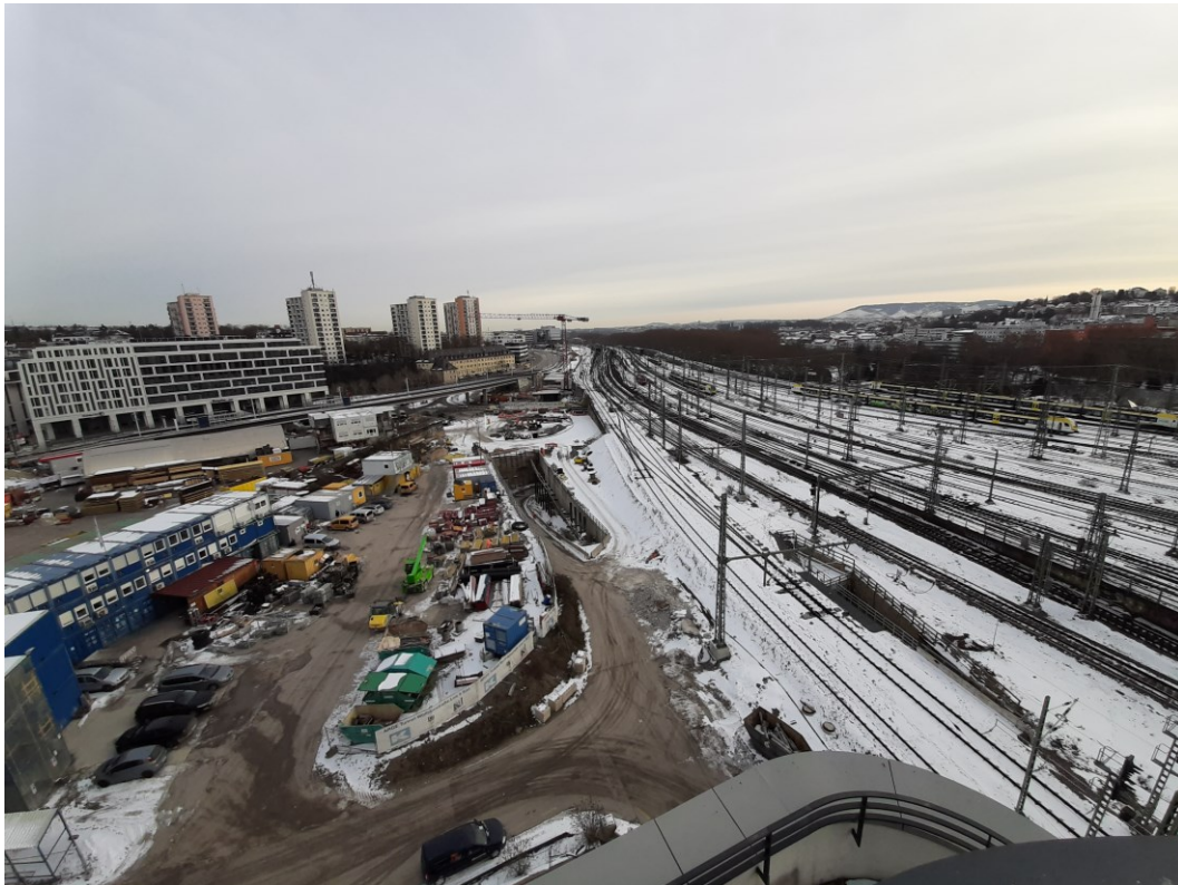
Abbildung 2: Blick auf das Baufeld bei Messende am 15.02.2021
