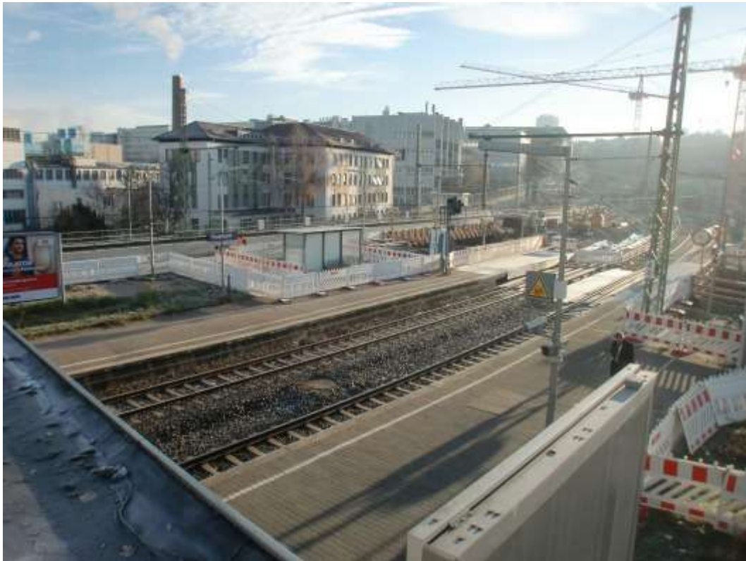
Abbildung 2: Blick auf das Baufeld bei Messende am 08.12.2016
