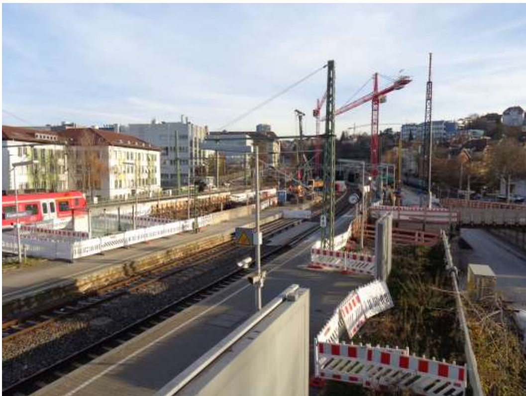
Abbildung 1: Blick auf das Baufeld bei Messbeginn am 01.12.2016
