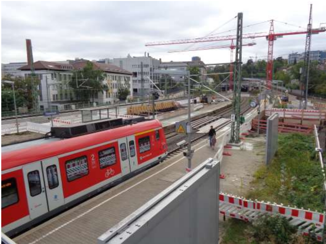
Abbildung 2: Blick auf das Baufeld bei Messende am 05.09.2016
