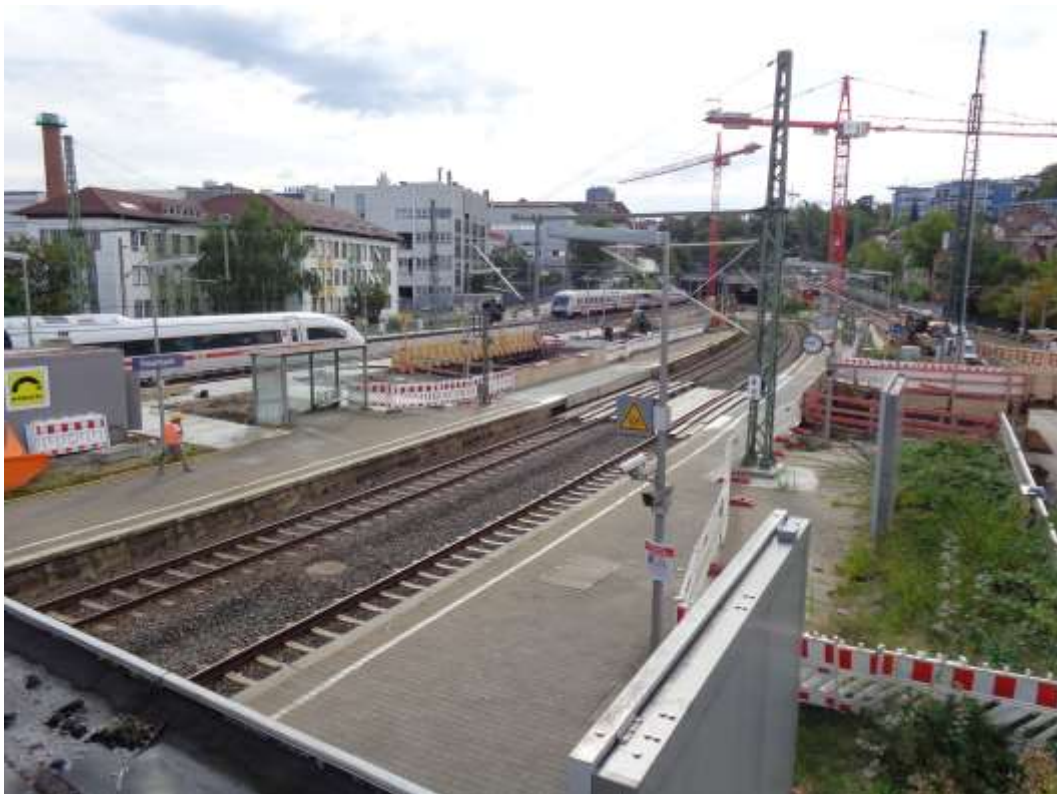
Abbildung 1: Blick auf das Baufeld bei Messbeginn am 29.08.2016
