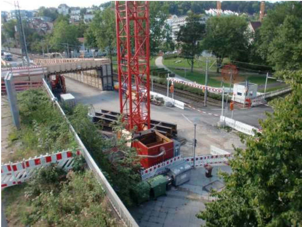
Abbildung 2: Blick auf das Baufeld bei Messende am 08.08.2016
