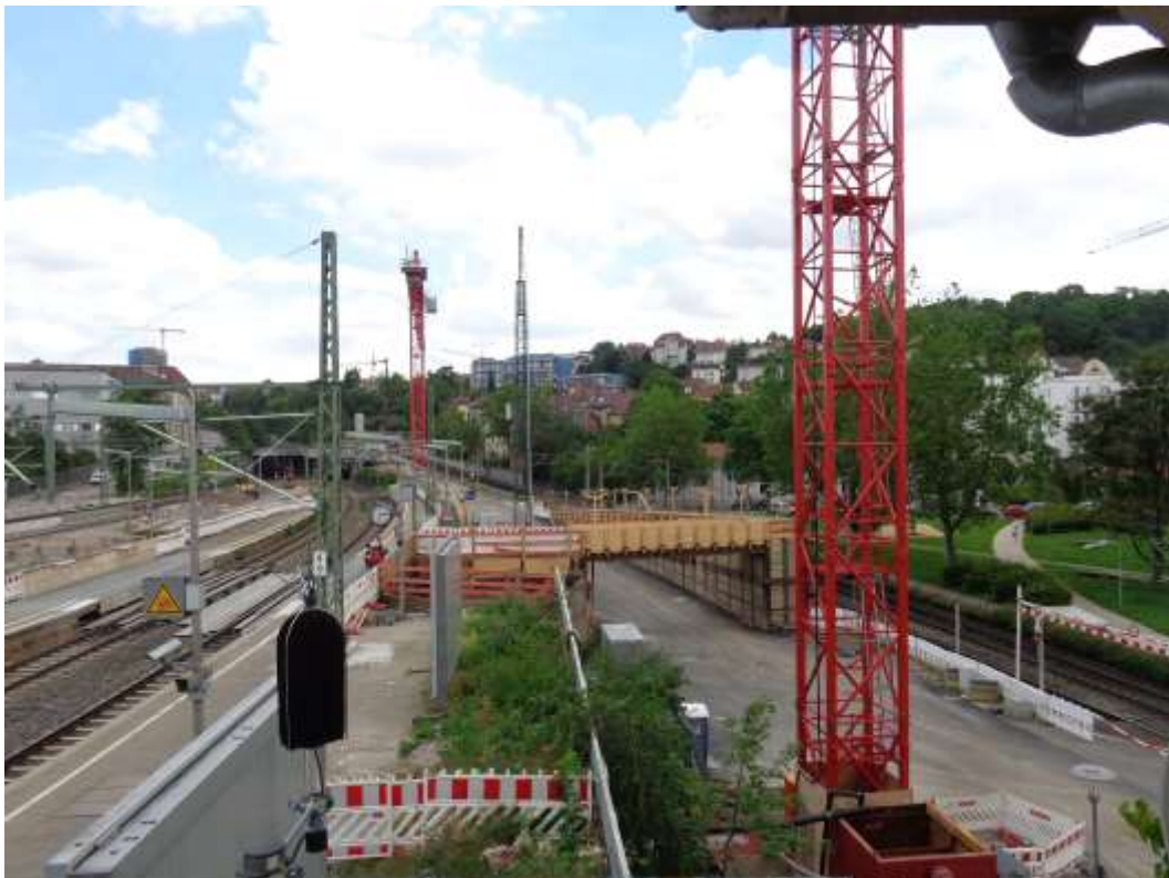
Abbildung 1: Blick auf das Baufeld bei Messbeginn am 04.07.2016
