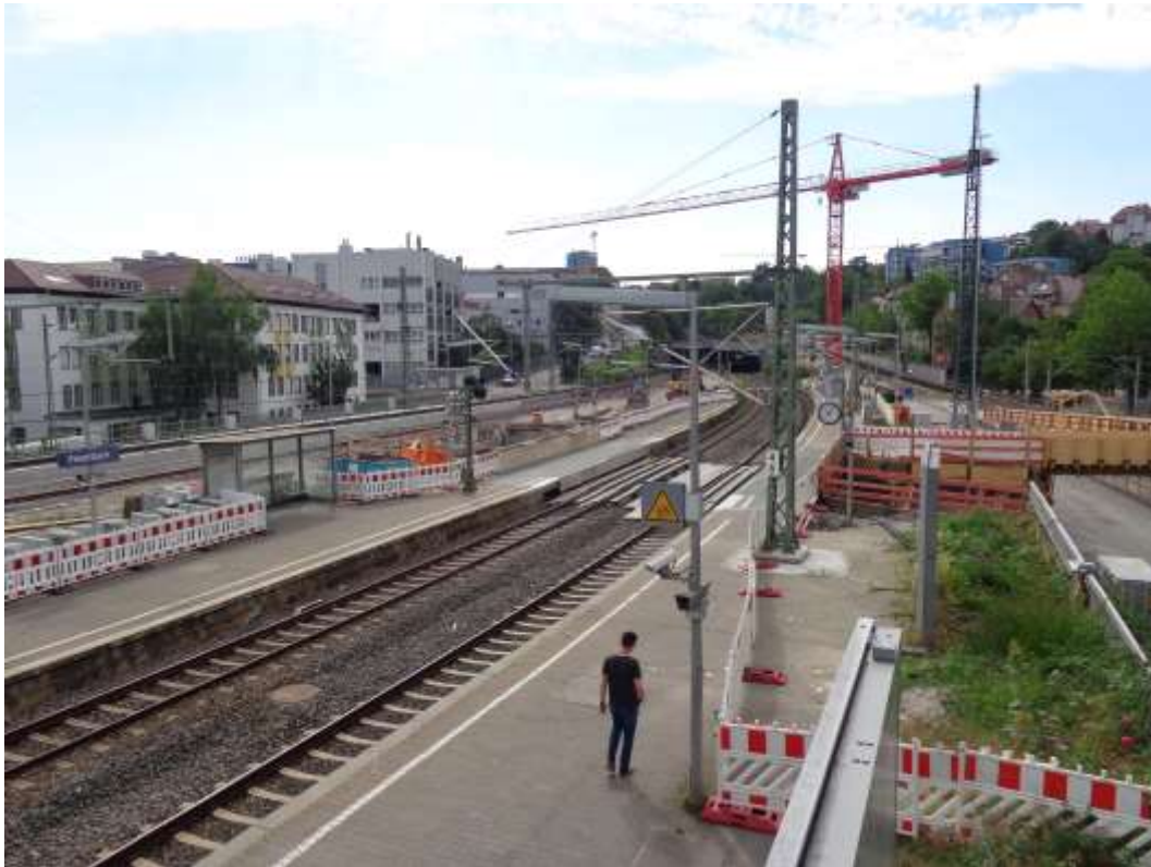
Abbildung 2: Blick auf das Baufeld bei Messende am 11.07.2016
