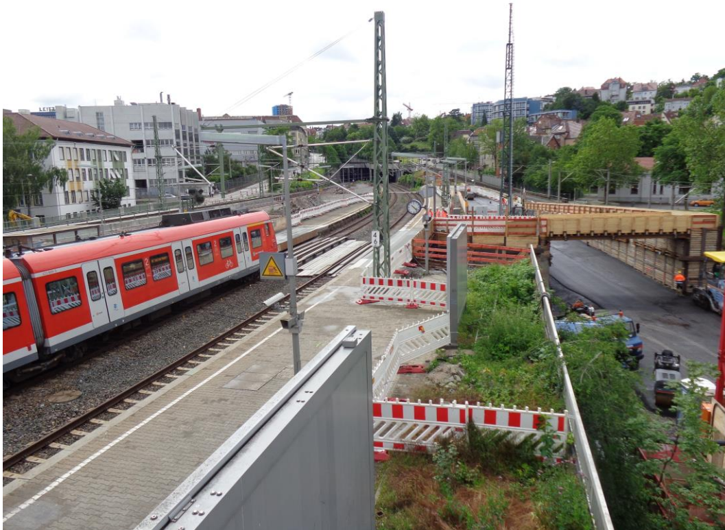
Abbildung 2: Blick auf das Baufeld bei Messende am 13.06.2016
