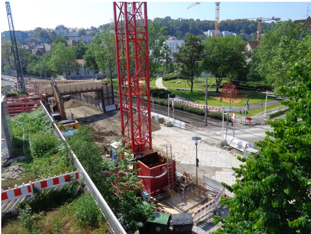
Abbildung 1: Blick auf das Baufeld bei Messbeginn am 06.06.2016
