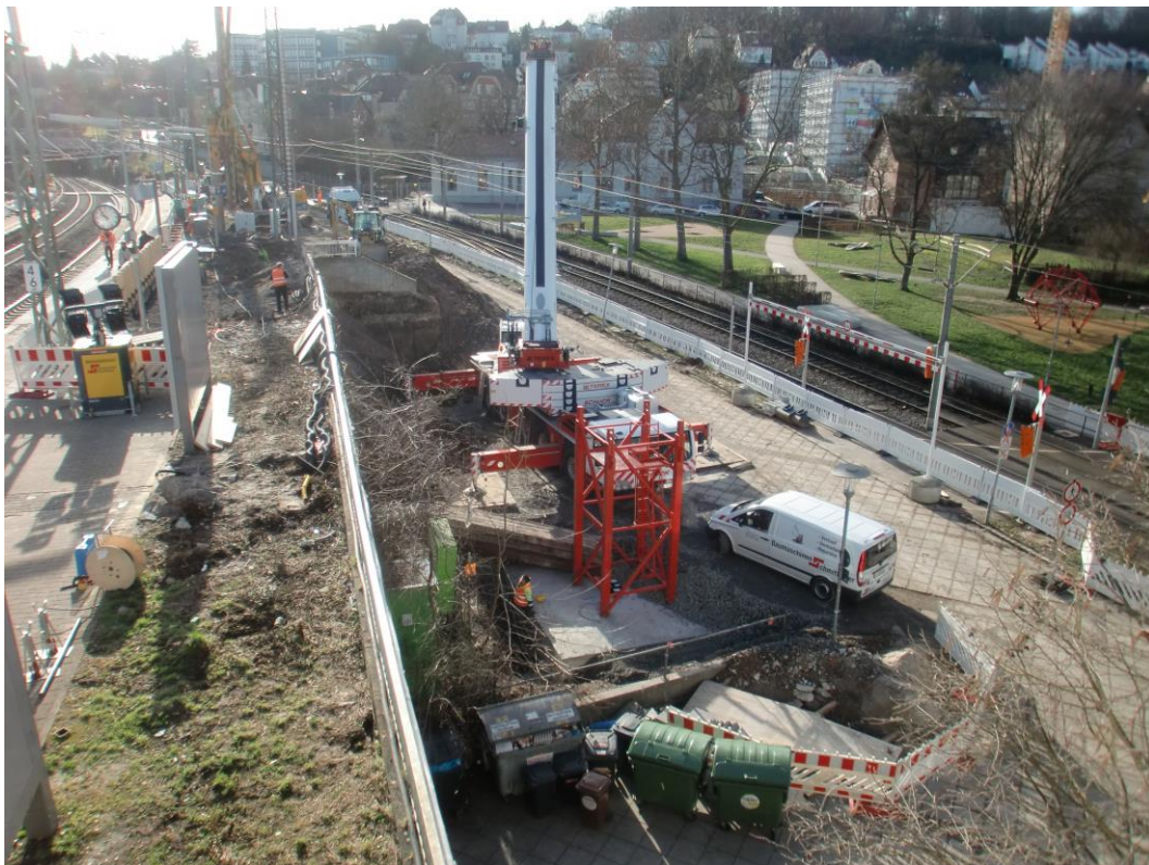
Abbildung 1: Blick auf das Baufeld bei Messbeginn am 22.02.2016
