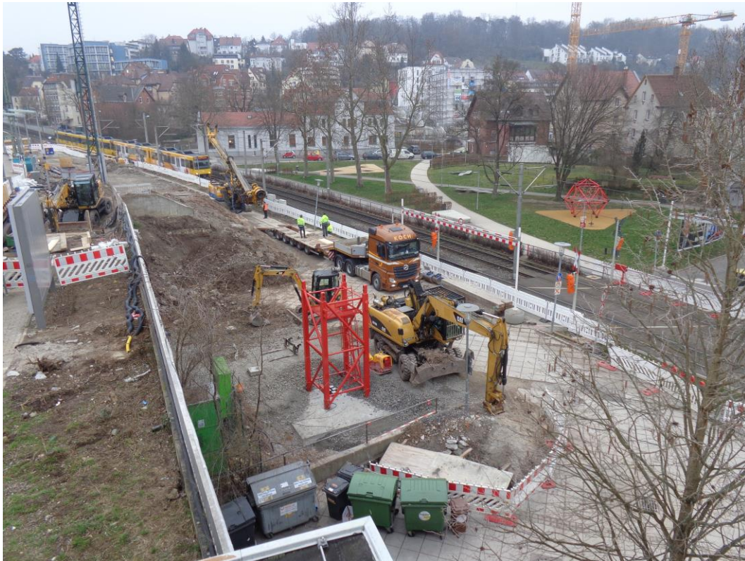
Abbildung 2: Blick auf das Baufeld bei Messende am 29.02.2016
