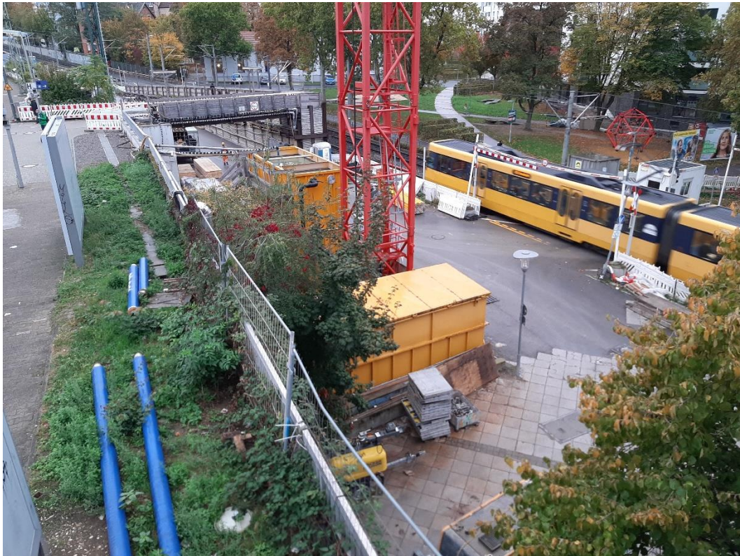
Abbildung 2: Blick auf das Baufeld bei Messende am 12.10.2020
