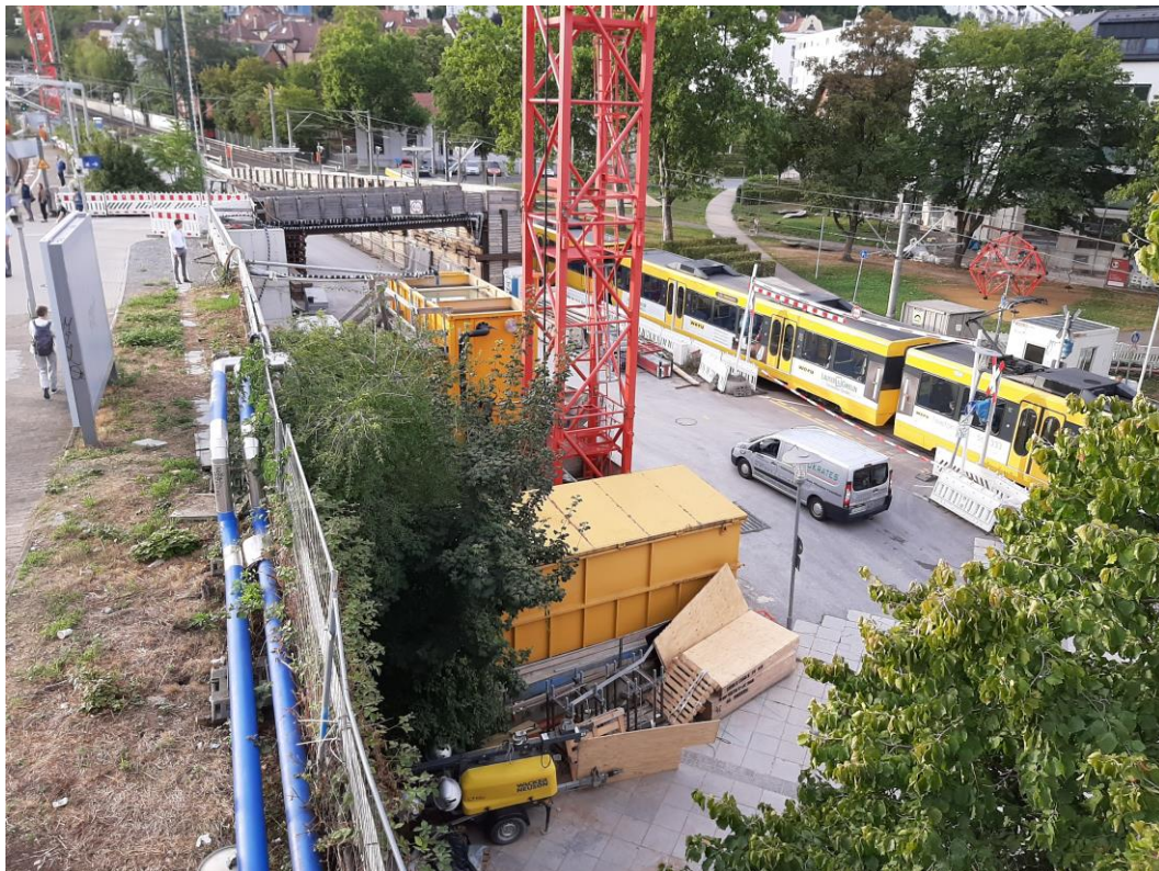
Abbildung 1: Blick auf das Baufeld bei Messende am 24.08.2020
